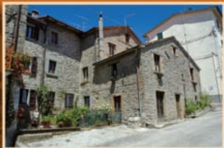
Tipiche abitazioni locali
